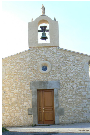
Eglise Aumelas – Rénovation de la Façade
