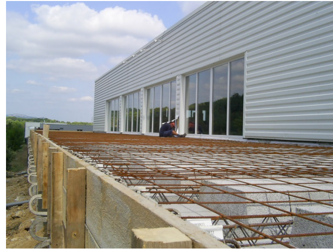
Imprimerie Saint Gély du Fesc - Extension
